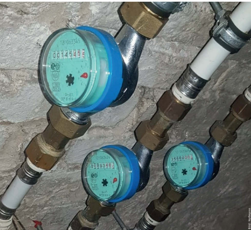
Drei Unterzähler für die einzelnen Abschnitte.
