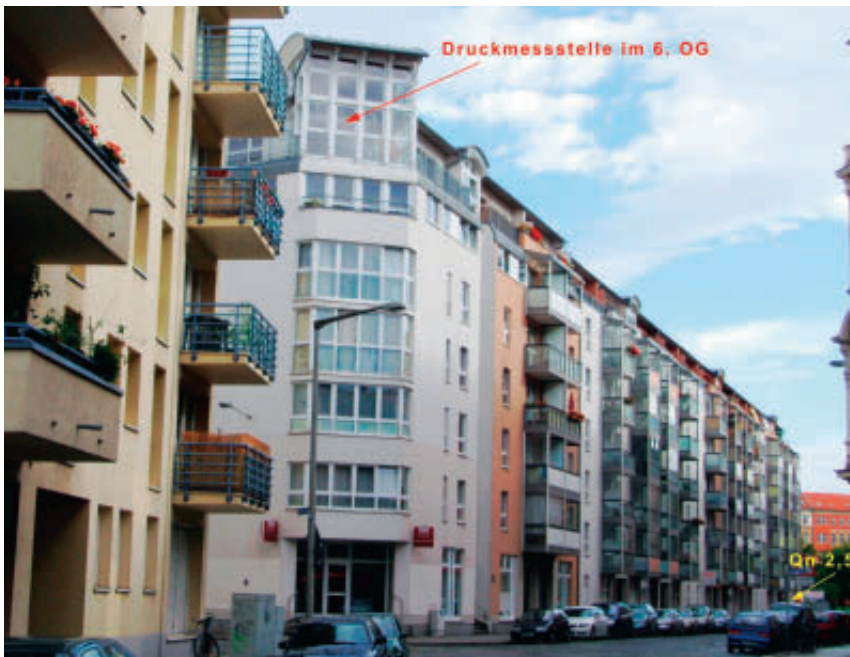
Abb. 9: Das Wohngebäude bestehend aus Erdgeschoss und sechs Obergeschossen und einer geodätischen Höhe von ca. 22 Metern
